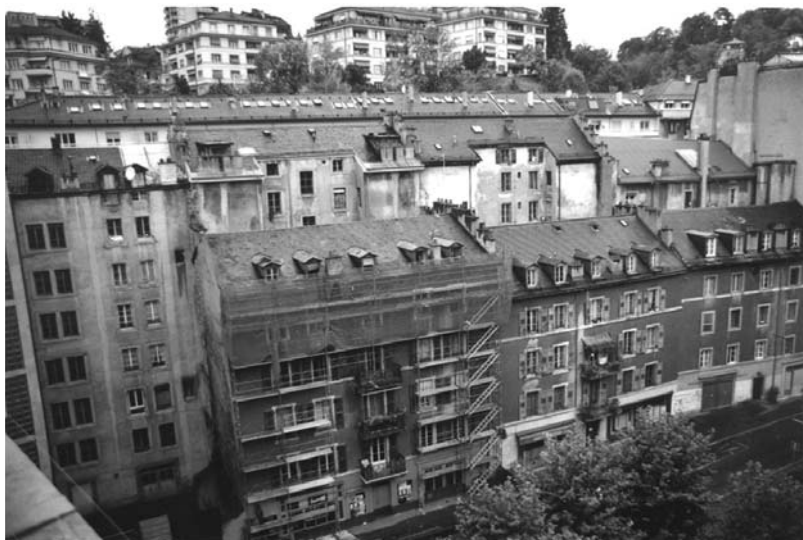
Illustration 1. Vue d'ensemble des immeubles du quartier Tunnel-Riponne.
