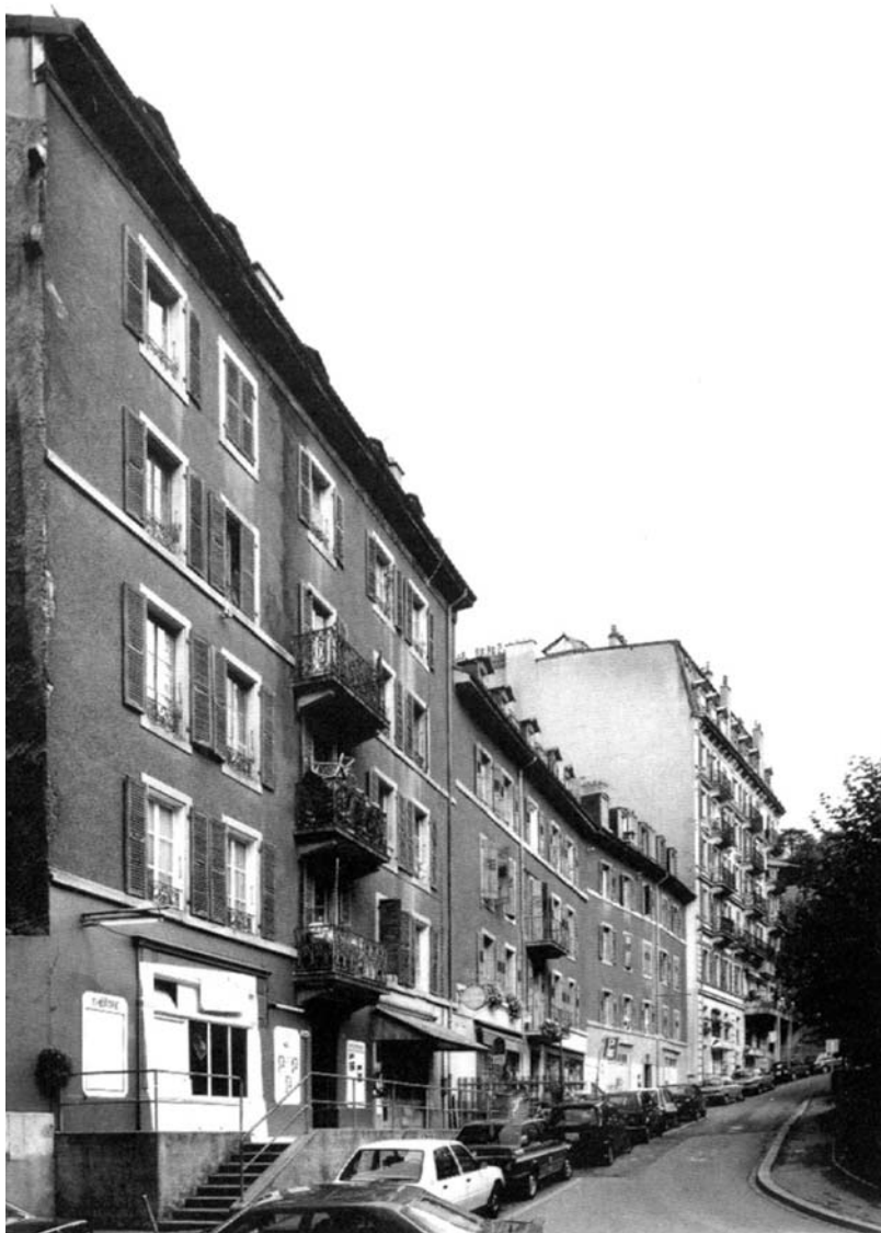
Illustration 2. Ilot Tunnel-Rippone : immeubles d'habitation.
